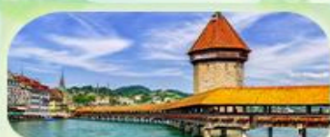
สะพานไมซ์าเปิล
