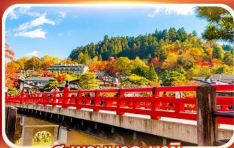
สะพานนากะบาชิ
