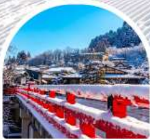
สะพานนากะบาชิ
