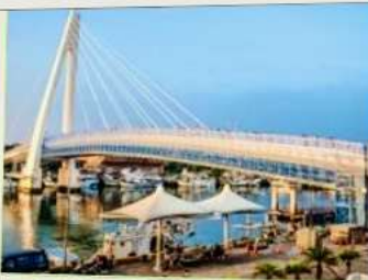
สะพานคู่รักตันส่วย
