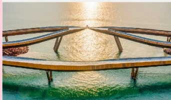
สะพานจูป
